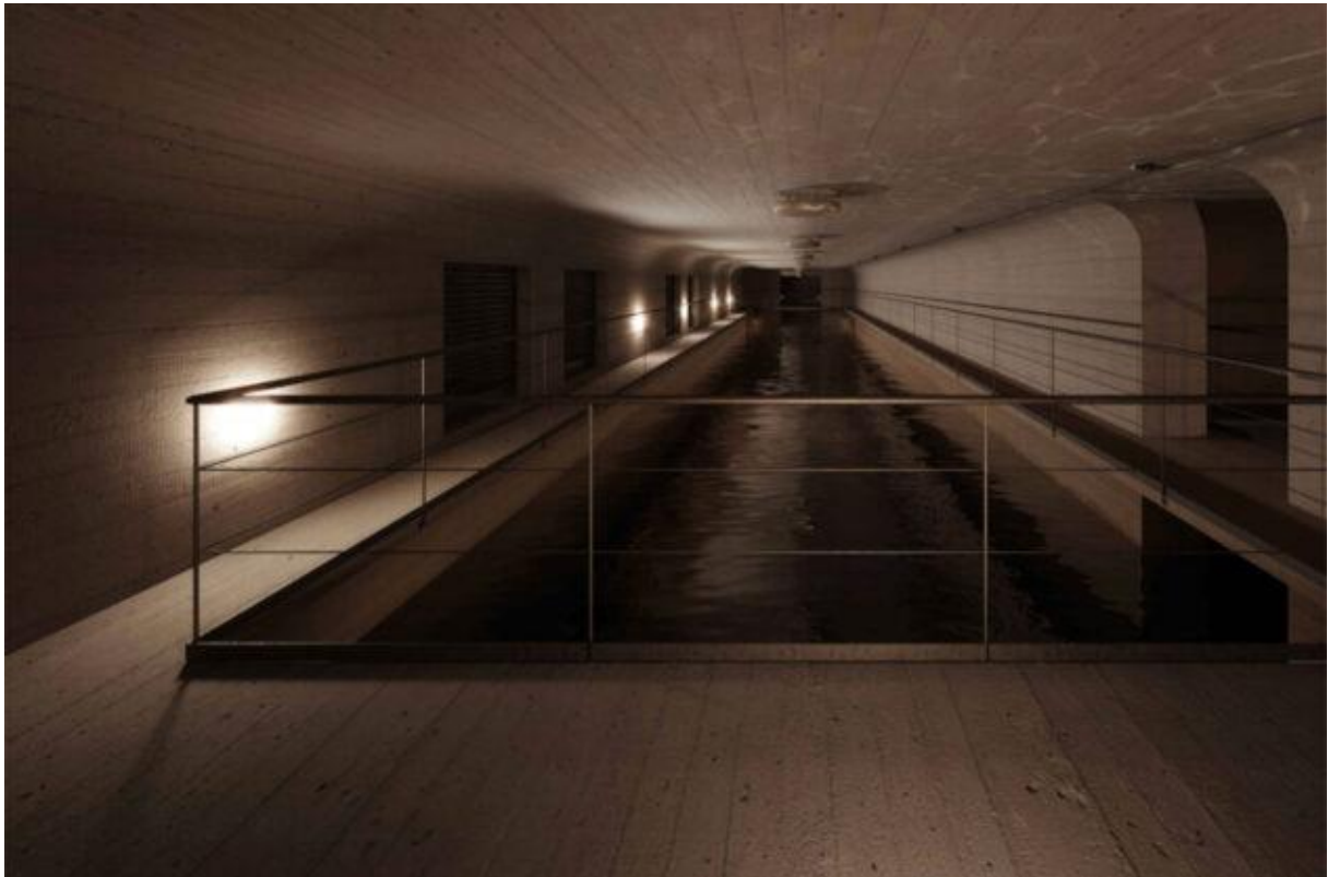
Ondergrondse reservoirs die opgevangen regenwater opslaan. Foto: Beaucastel / BAM
