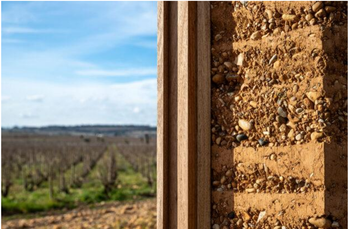
De grond die op de locatie wordt uitgegraven, wordt gebruikt om pisé (aangestampte aardeblokken) te maken voor de bouw van nieuwe gebouwen boven de grond. Foto: Nicolas Facenda
