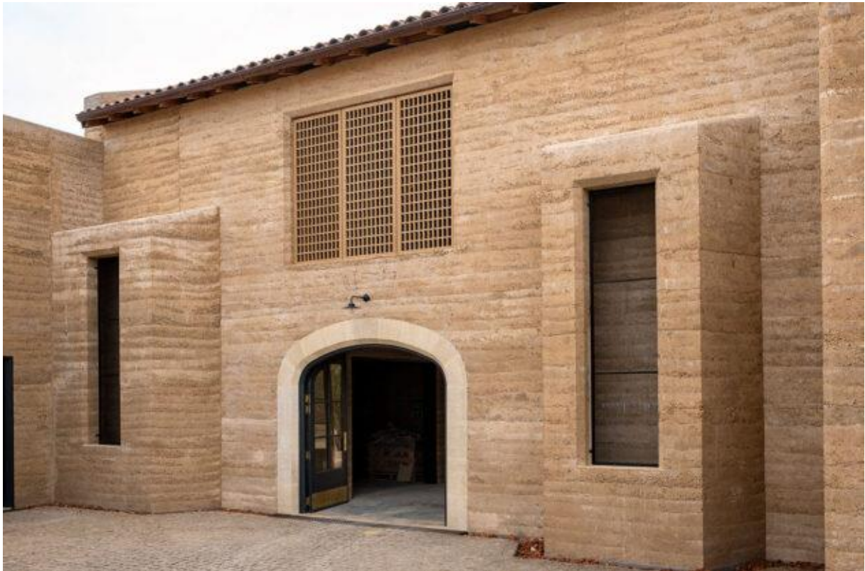
De koele Mistral stroomt via kanalen en openingen naar binnen, stroomt in ondergrondse galerijen en fungeert als natuurlijke ventilatie voor de wijnmakerij en diverse gebouwen. Foto: Nicolas Facenda
