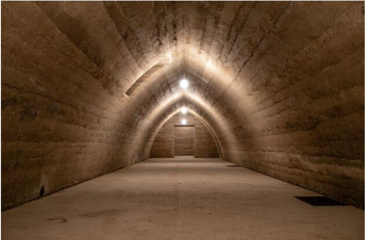
Ondergrondse secties zijn gemaakt van 'terreinbeton': een mengsel van kalk, lokale aggregaten en zand dat op de bouwplaats is uitgegraven. Foto: Nicolas Facenda
